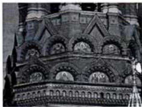
открытая аркада звонницы, на массивных пилонах, декорированных массивными византийскими полуколоннами и угловыми четвертьколоннами;
