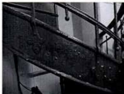
металлическая лестница в три ступени с кованым ограждением и деревянным профилированным поручнем;
