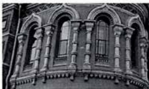
стилизованные лопатки в уровне второго и третьего яруса оконных проемов (окна двусветного храмового пространства), фланкирующие тройные оконные проемы и в угловых зонах: двухъярусные, с тремя рядами поставленных друг над другом трехчетвертных колонок в угловых зонах, с «дыньками» и перехватами, декорированными лепными поясами «перевитого жгута»; в верхней части – стилизованная ложная балюстрада из «бочарных» колонок (известняк), между ярусами – профилированный карниз с поясами бус и жемчужника;
