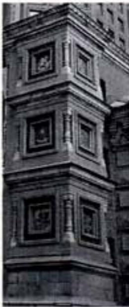
второй ярус башенного объема, со срезанными углами – отделка стен по трем сторонам неглубокими нишами в профилированном обрамлении с мозаичными вставками с геральдическими символами; в центральной части северного и южного фасадов второго яруса башенного объема – большие прямоугольные ниши в профилированных обрамлениях под многофигурные мозаичные композиции; венчающий профилированный карниз стен с мозаичными панно с порезкой бусы;
