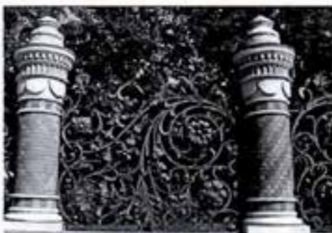
воротные столбы в виде 4-х ярусного пилона облицованного кирпичом, сдвоенного с полуколонной (декор колонны аналогичен декору тумб);
