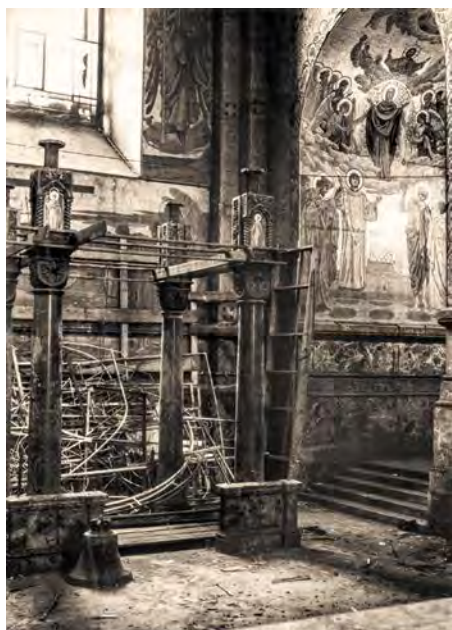
Фрагмент фасада и разрушенная сень храма во время передачи здания Государственному музею-памятнику «Исаакиевский собор». 1971 год
