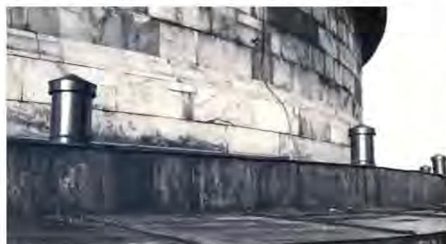
Трубы вентиляции Исаакиевского собора, 1955 год (© СПб ГБУК «Государственный музей-памятник «Исаакиевский собор», 2023)
