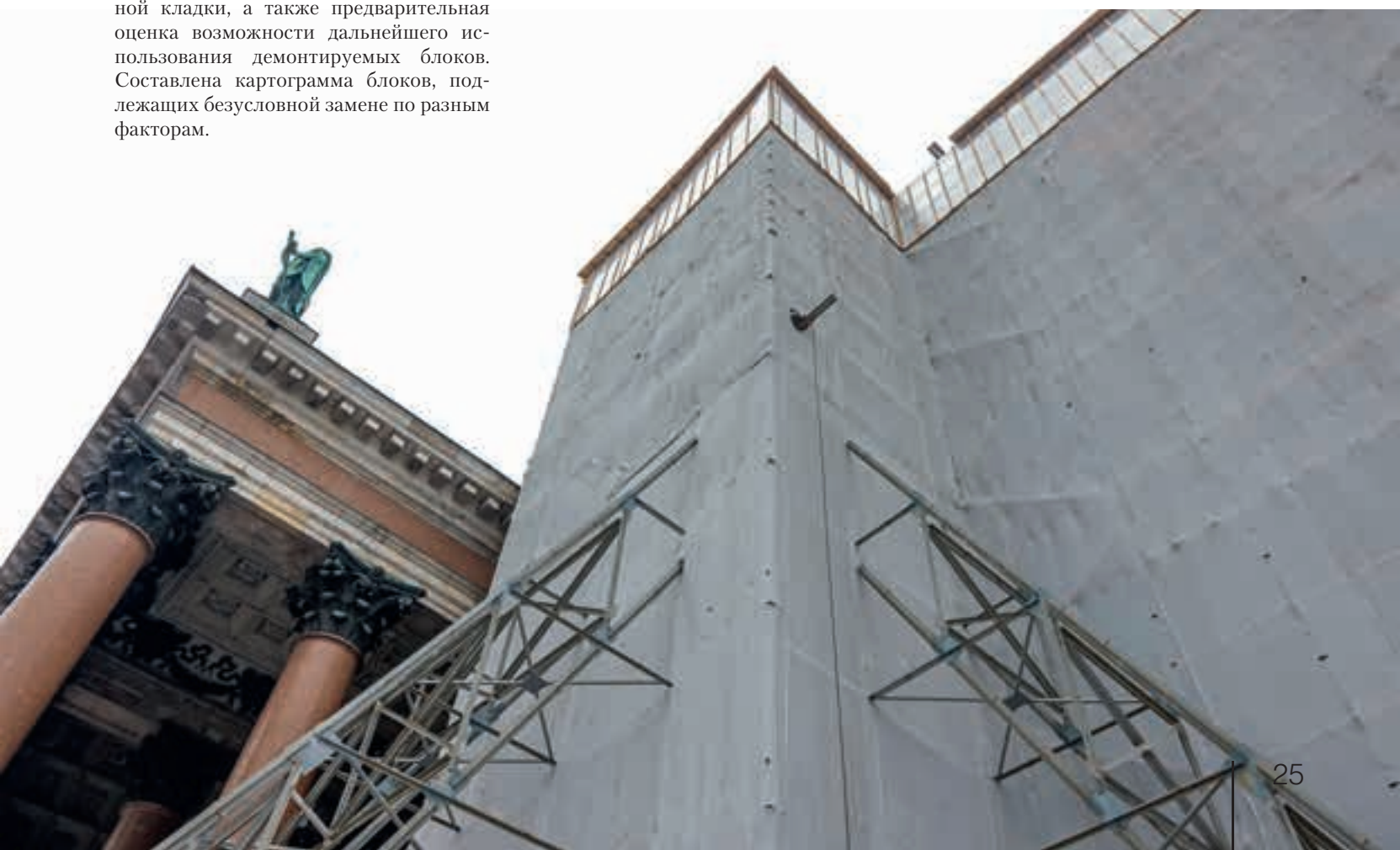
Строительные леса на северо-западном углу собора. 2025
