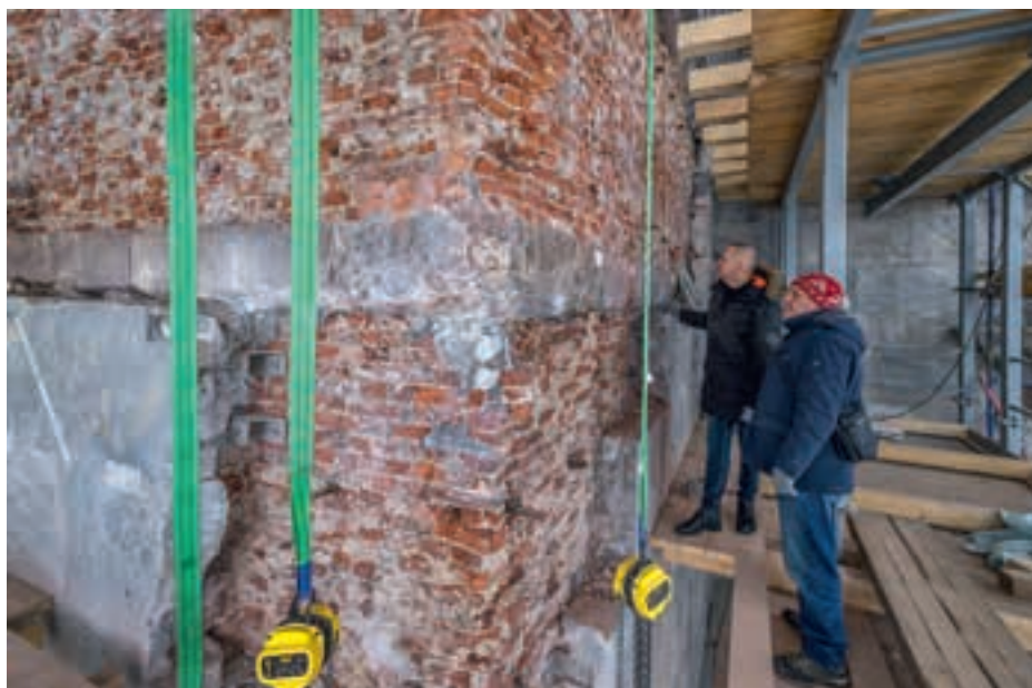
Кирпичная кладка и прокладные гранитные плиты после снятия мраморной облицовки. 2025
