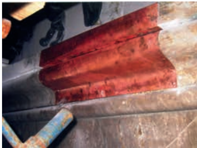
Замена мрамора на выколотную медь. 2000-е
